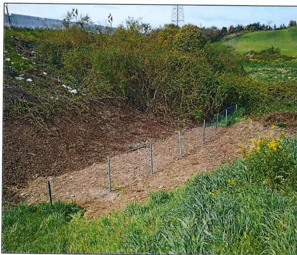
Figura 6.1 – Il sito ripristinato.
